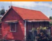
Case en tôle toit deux pans
